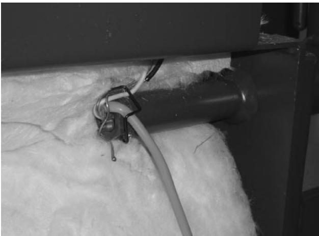
Рис. 15 – датчик температуры воды ТК, установленный в отверстии котла DCxxSP(EP) или котла с горелкой в верхних дверцах DCxxS(X), CxxS, ACxxS, DCxxRS
