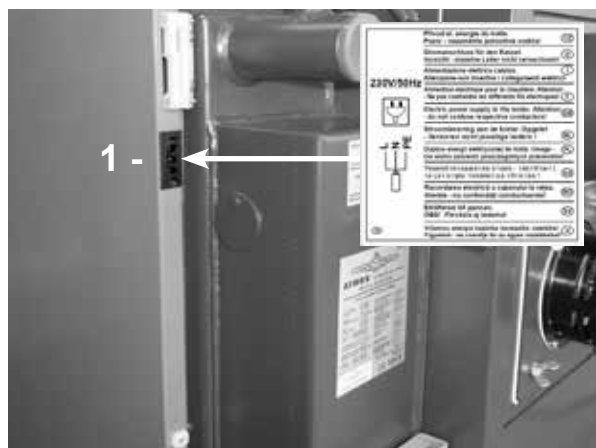
Разъем капотом справа котла
