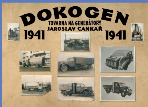
Производство и монтаж генераторов древесного газа «ДОКОГЕН»
